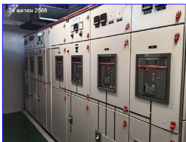
รูปที่ 2.14 ตู้ MDB (Main Distribution Board)
