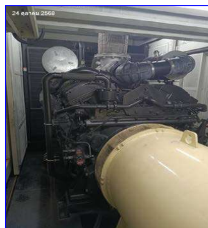
รูปที่ 2.13 เครื่องสำรองไฟฉุกเฉิน
