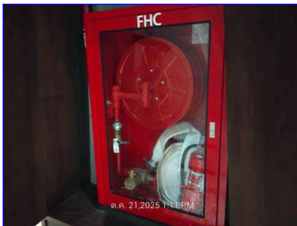
รูปที่ 2.23 ชุดตู้ดับเพลิง
