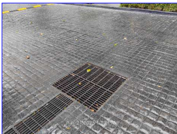
รูปที่ 2.29 ตะแกรงดักขยะ
