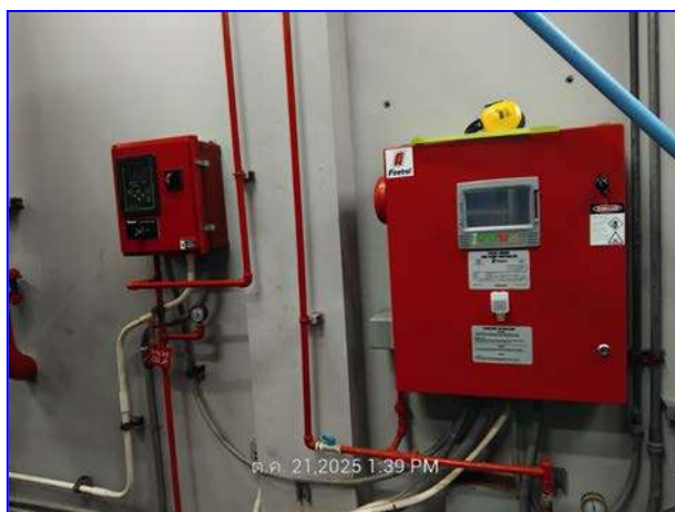
รูปที่ 2.41 ระบบ Fire Pump
